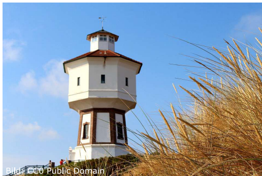
Wasserturm auf Langeoog
